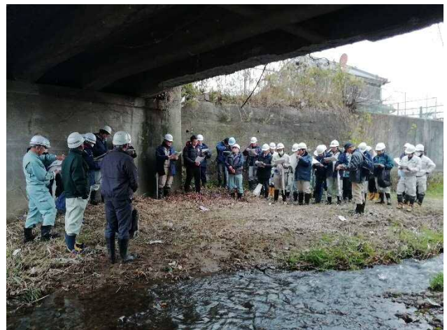
▲ 奈良市からの近接目視点検結果説明
