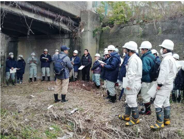
▲ 飯合橋での現地技術研修(第1部・桁下面)
